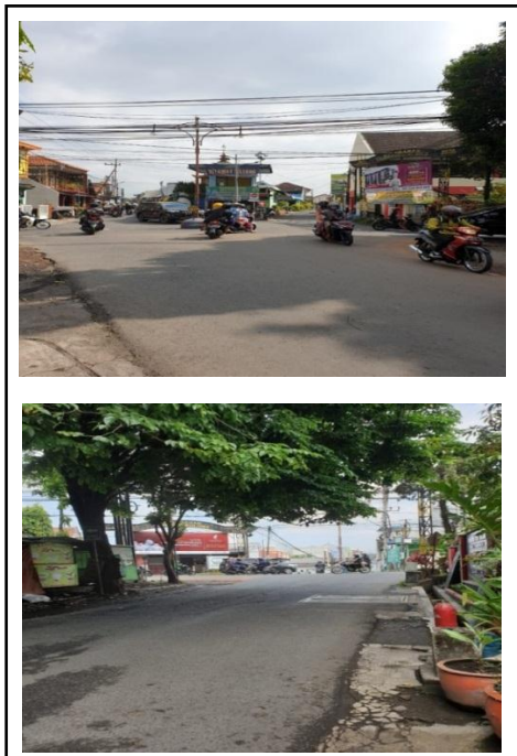
Gambar 7. Kondisi di Sekitar Simpang 5 Jl. Tunggulwulung
