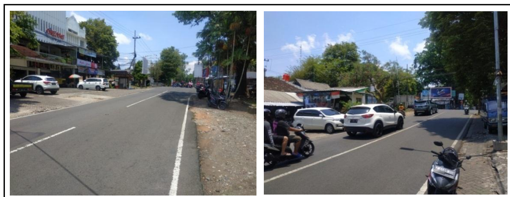
Gambar 4. Kondisi di Sekitar Simpang Empat Jl. Retawu- Jl. Bondowoso
